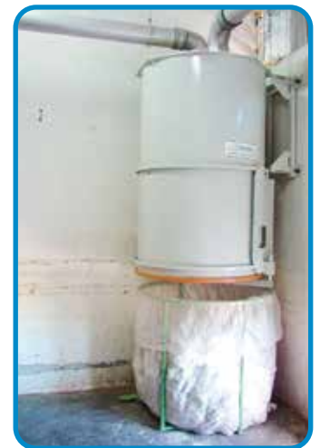
Versione standard senza compattatore, apertura manuale del coperchio
