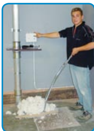
Resíduos no piso são levados ao ponto de coleta através de um aspirador
