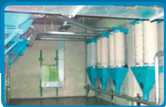
Coleta de resíduos dos coletores de pó nos sistemas de condicionamento de ar
