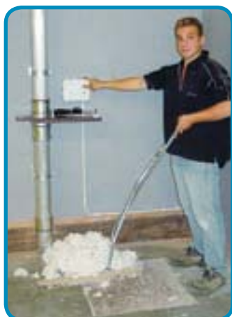
El barrido recogido con la escoba tijera es transportado hasta el filtro a través del punto de barrido
